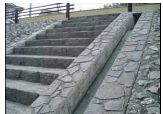
公共工事の河川工事にも
