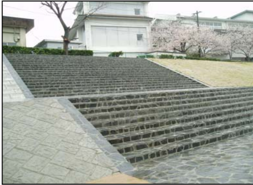
(鉄平石の施工例)
